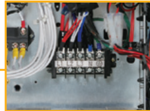
Dış ünite güç besleme terminal bloğu
